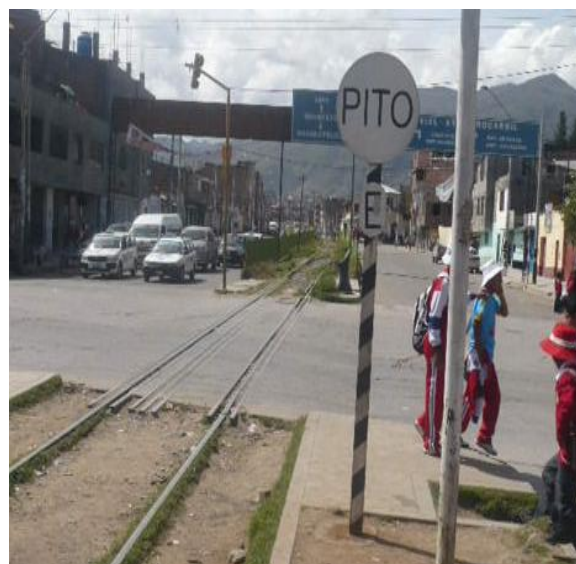
Av. Ferrocarril, cruce con Av. Huancavelica, Chilca
